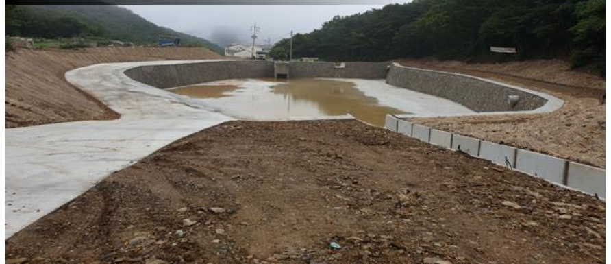
담동항 화물부두 접안시설 설치 공사
