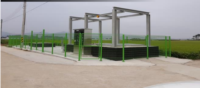
삼산지구 농업용수공급사업 토목공사
