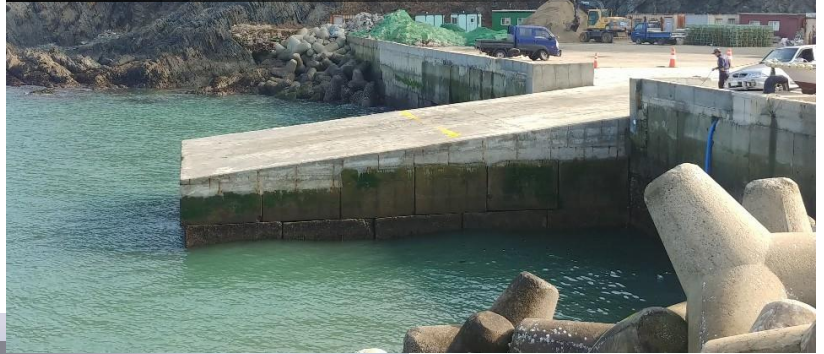
담동항 화물부두 접안시설 설치 공사
